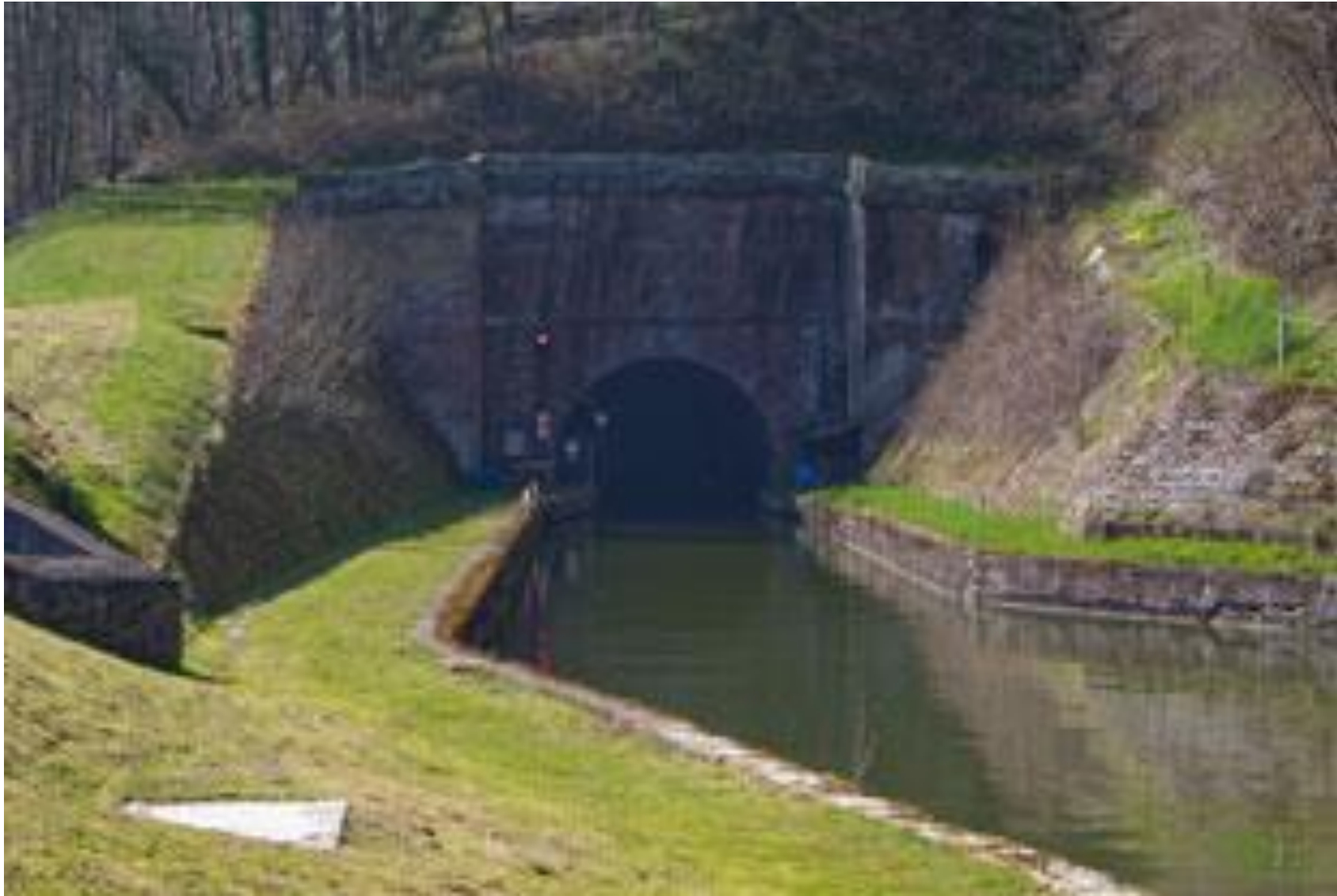
Bild: 2310 Meter langer Tunnel des Canal de la Marne au Rhin in der Nähe von Arzviller, 25 km vor Gondrexange ... Hier sind wir am 3. Tag ...
